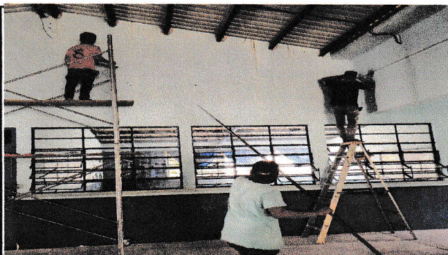
Foto 4: VISTA PREVIO, AREA A INTERVENIR.
