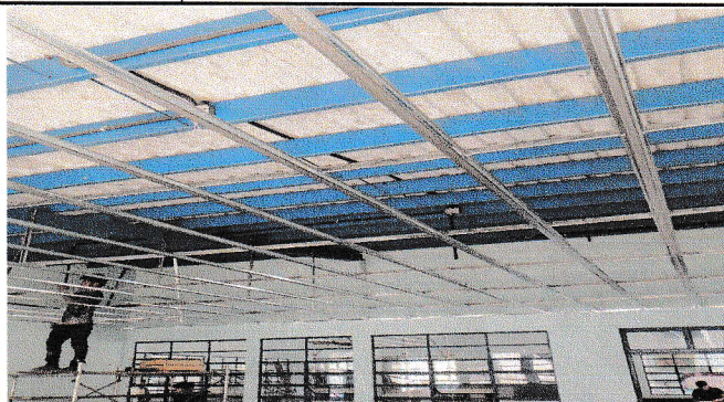
Foto 2: VISTA PREVIO, AREA A INTERVENIR.
