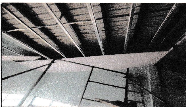
Foto 3: VISTA PREVIO, AREA A INTERVENIR.
