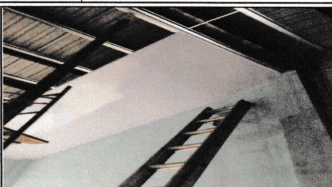
Foto 2: VISTA PREVIO, AREA A INTERVENIR.
