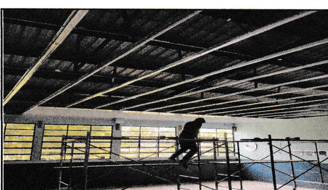
Foto 4: VISTA PREVIO, AREA A INTERVENIR.
