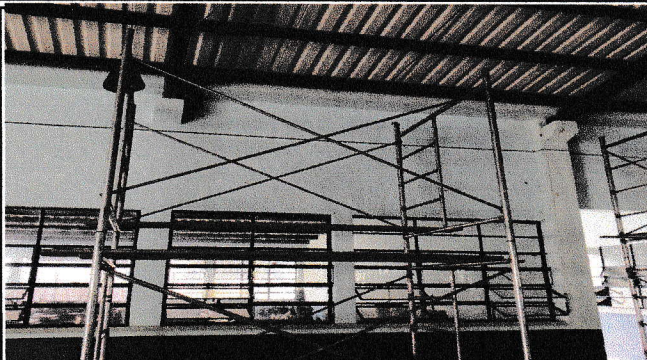
Foto 2: VISTA PREVIO, AREA A INTERVENIR.
