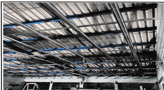
Foto 3: VISTA PREVIO, AREA A INTERVENIR.
