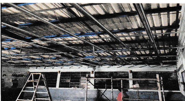
Foto 6: VISTA PREVIO, AREA A INTERVENIR.
