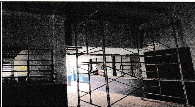
Foto 1: VISTA PREVIO, AREA A INTERVENIR.
