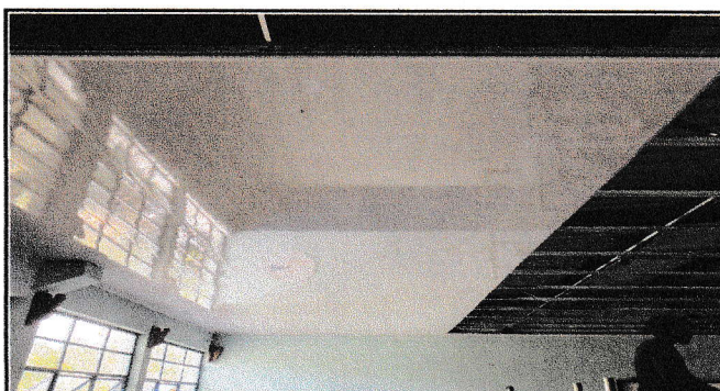
Foto 5: VISTA PREVIO, AREA A INTERVENIR..
